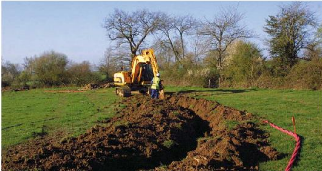
Enfouissement de lignes électriques
